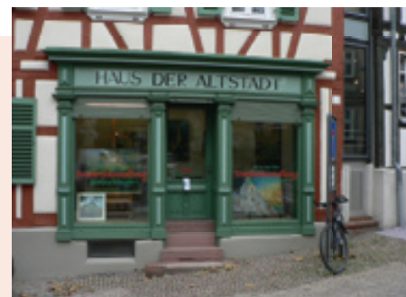
▲ Frisch saniert: das Bürger- und Vereinsgebäude „Haus der Altstadt“.
